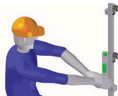
**12** Colocar los montantes de seguridad para el nivel superior.
