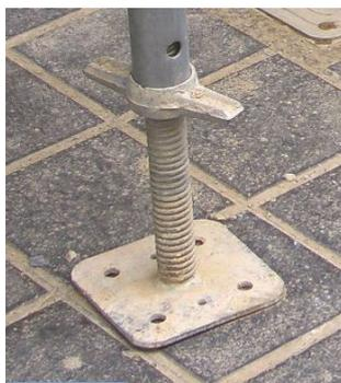
Placa base rectangular con husillo. Las bases de apoyo tendrán un espesor mínimo igual a 6 mm y un área mínima de 150 cm<sup>2</sup>.
