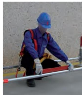
Nivelación de un andamio mediante un nivel de burbuja.
