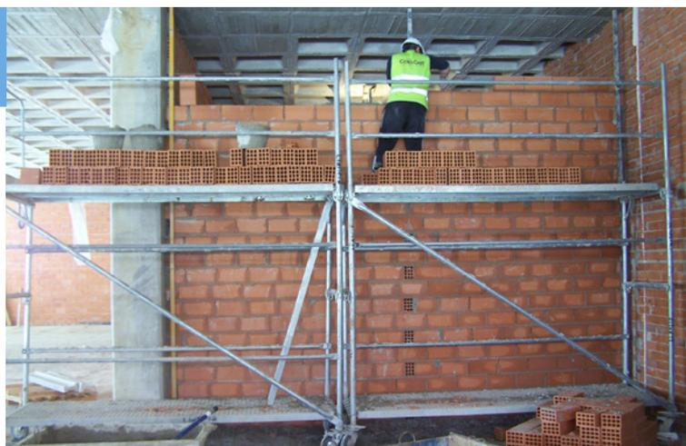
■ Aunque se conozca la capacidad de carga de las plataformas (carga máxima admisible por plataforma), hay que tener en cuenta que, en una hipótesis normal de uso, para el cálculo del andamio, no se prevé que todas las plataformas soporten simultáneamente la máxima carga admisible. El calculista, en función del uso, habrá dado un coeficiente mayor o menor de simultaneidad a esta carga que siempre estará muy alejado de 100%.
