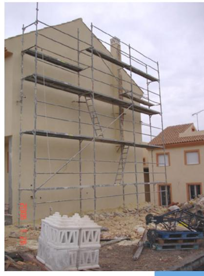
Detalle de andamio unidireccional de fachada, con ausencia de elementos de protección en las áreas de trabajo
