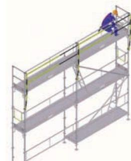
**7|** Desmontaje de las barandillas. El desmontaje de las barandillas laterales debe realizarse con el arnés amarrado a las barandillas o largueros.
