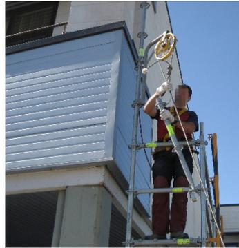
Las zonas de acopio y de izado de materiales deben estar acotadas y señalizadas.
