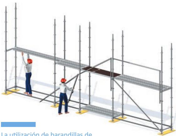
La utilización de barandillas de montaje representa un método de protección eficaz frente al riesgo de caída de altura
