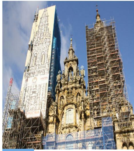
Un andamio con revestimiento requiere mayor sujeción porque se puede producir el efecto vela, debido al viento.
