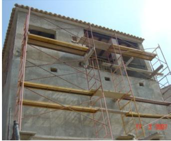
El andamio de la imagen se muestra como ejemplo de diagonalización con cruces de San Andrés, pero presenta numerosas irregularidades: accesos inadecuados, falta de plataformas, tamaño insuficiente de las plataformas, ausencia de protecciones colectivas, etc.
