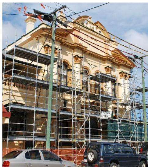
Andamio montado en las proximidades de un tendido eléctrico.
