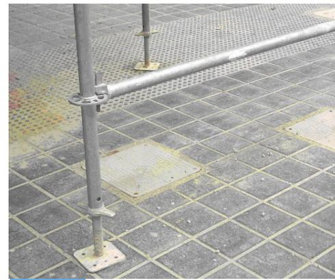
Configuración errónea de las bases regulables para evitar su instalación sobre una arqueta
